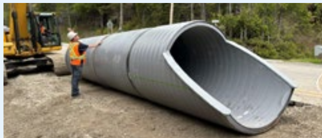
Installation d'un nouveau tuyau sur la Route 132 à Percé. Mention de source : ADS, gracieuseté
