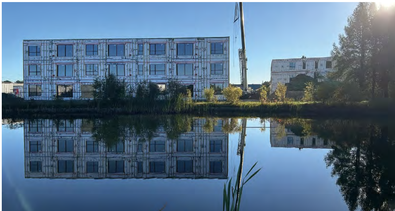
Deux bâtiments de 18 appartements sont en construction à Saint-Honoré-de-Shenley. Mention de source : Municipalité de Saint-Honoré-de-Shenley, gracieuseté.
