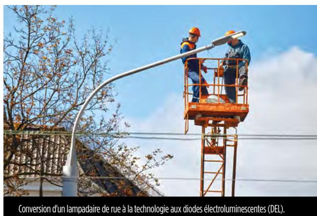
Conversion d'un lampadaire de rue à la technologie aux diodes électroluminescentes (DEL).
