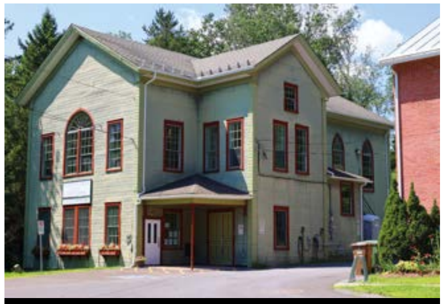
Le programme Éco Énergie 360 permet aux municipalités d'améliorer l'efficacité énergétique de leurs bâtiments municipaux.
