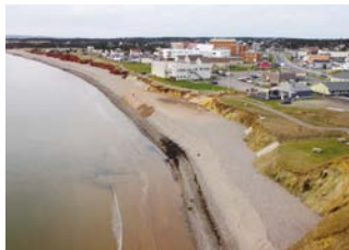
Travaux de stabilisation de falaise à Cap-aux-Meules aux Îles-de-la-Madeleine (2022)
