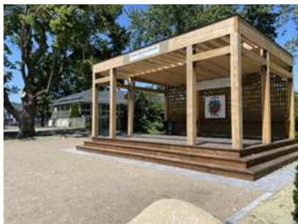
Le nouveau pavillon à usages multiples permet de faciliter l'enseignement extérieur pour les enseignants et les élèves de l'école de l'Amitié.
